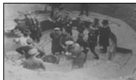
Moment wmurowania kapsuły w fundamentach wieży ciśnieniowej
