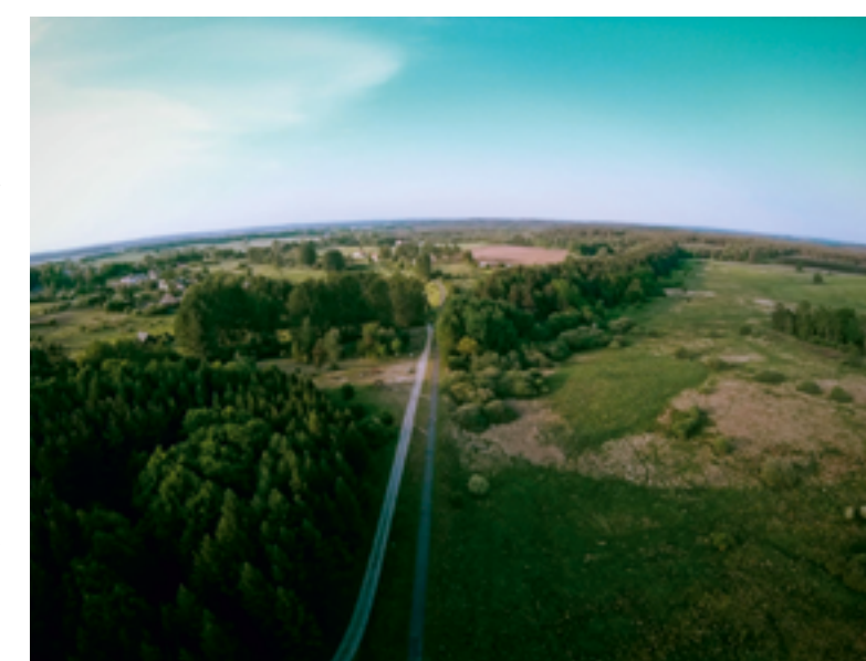
Fragment autostrady, który łączył się z „Berlinką” na wysokości wsi Cieszyno - tworząc węzeł Falkenburg fot. M.Kaliniak
