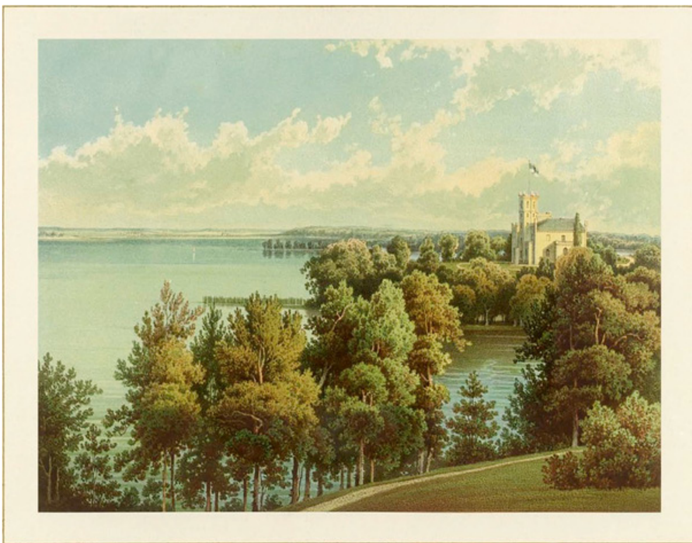
Karwicki pałac nad jeziorem Lubie. Litografia Dunckera. Dwukondygnacyjny budynek zbudowano w stylu angielskiego neogotyku na podstawie prostokąta z dwoma ryzalitami i smukłą wieżą.
