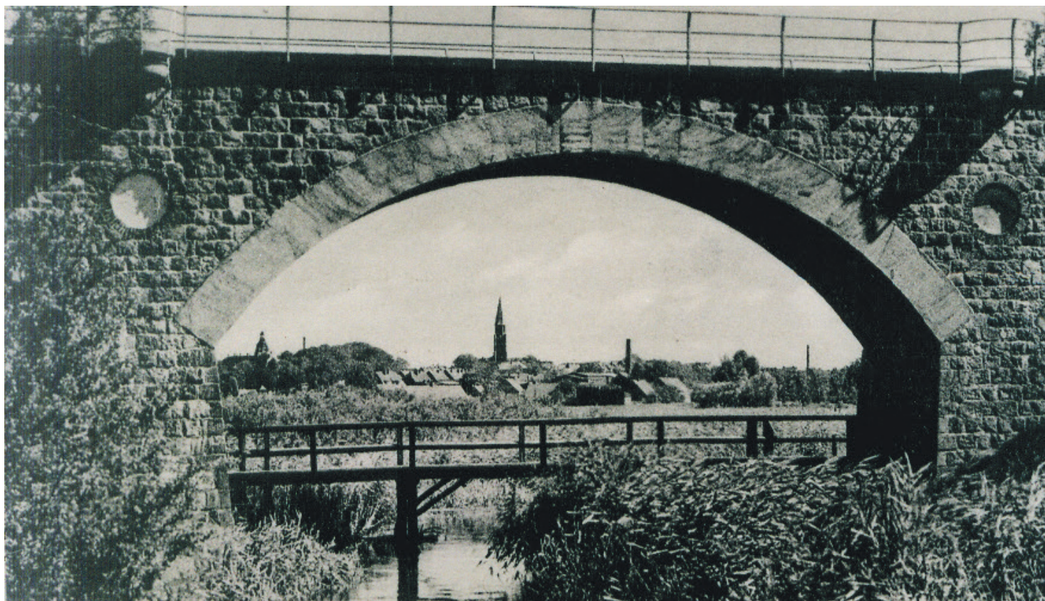
Most kolejowy na Drawie w Złocieńcu
