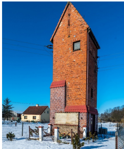
Wieża transformatora z wmurowaną tablicą; u góry widać okienko pomieszczenia, w którym bronili się radiotelegrafści 2 Pułku Ułanów; fot. Maciek Leszczelowski
