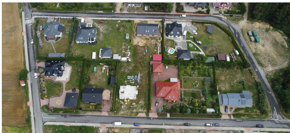
Budowa nowej drogi ul. Warszawskiej i Pyrzyckiej oraz przebudowa ul. Brzozowej w Złocieniu wraz z budową kanalizacji deszczowej Całkowity koszt realizacji zadania wyniósł 5 354 095,38 zł
