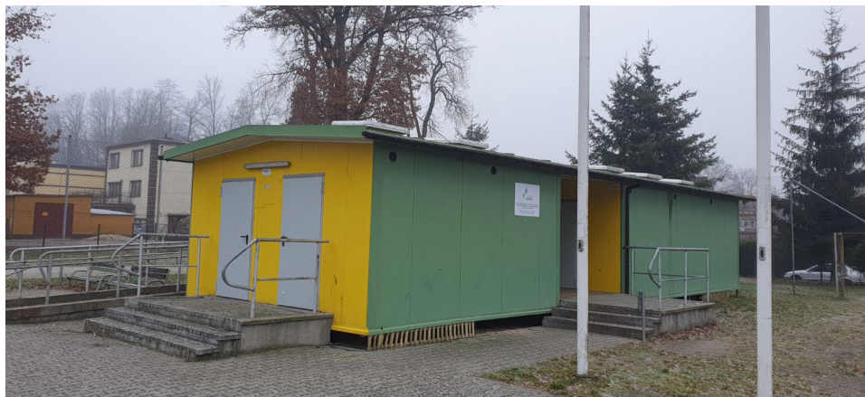
Remont i modernizacja boiska Orlik wraz z zapleczem socjalnym przy Szkole Podstawowej Nr 1 im. Janusza Kusocińskiego w Złocieniu Całkowity koszt inwestycji wyniósł 72 007,64 zł
